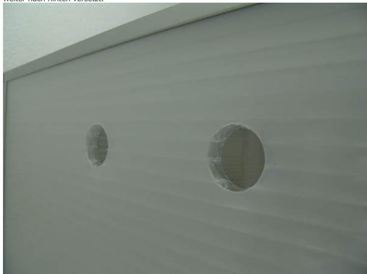
Die Kunststoff-Abdeckungen wurden mit Uhu plus eingeklebt, alternativ geht auch Silikon, dies schmiert aber mehr.
