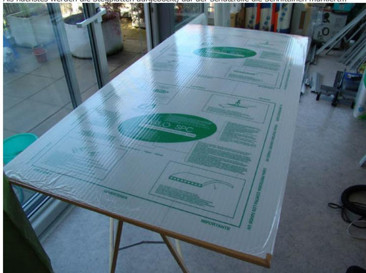
... und mit der Stichsäge die Platten zugeschnitten. Unbedingt Schutzbrille und möglichst auch Gehörschutz tragen. Beim Sägen entstehen kleine Kunststoffteile, die herumspicken. Eine Absaugung mit dem Staubsauger lohnt sich auf jeden Fall.
